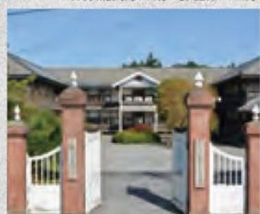
明治21年(1888年)に建てられ、明治の洋風学校を代表する建築物として昭和56年国の重要文化財に指定されました。設計監督は宮城県技手(県庁職員)山添喜三郎によるもので、純木造の2階建て、南を正面にコの字型をとり、1階2階ともに吹き抜けの片廊下式となっております。また、採光として教室は両側にガラス窓を贅沢に使用しています。特徴的なのが2階バルコニーで、校舎全体の中心的な位置にあり、シンボリックな役割を果たしています。左右対象の東西昇降口は六角形を半割にしたトラス工法をもち、屋根は寄棟瓦葺きのシンプルさで全体を機能的にまとめあげた建築です。昭和48年まで使用された教室をそのまま残した再現教室や各時代の教科書・教材・器具など懐かしい展示品もご覧になることができます。
